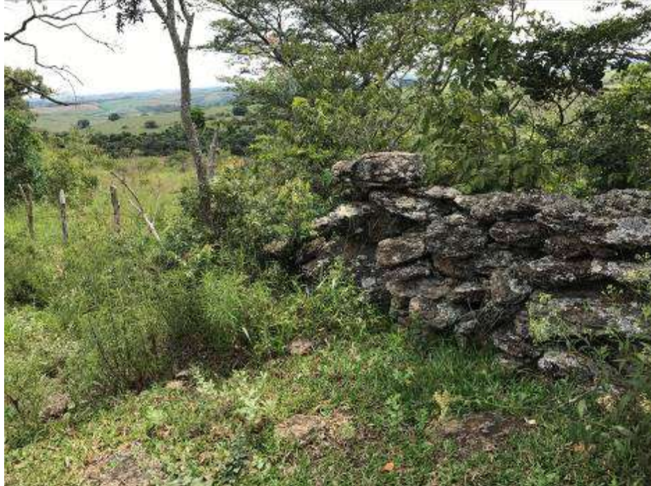
Figura 9 – Trecho de mureta de pedras. Município de Madre de Deus de Minas (MG).
