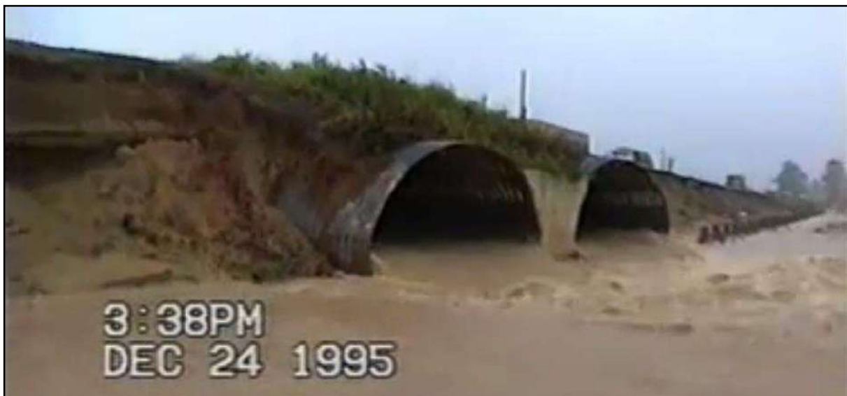
Figura 1: Imagem do túnel no dia 24 de dezembro
