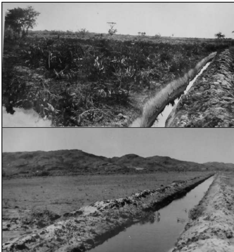
Figura 2: Valas de drenagem, com a vegetação queimada ao lado, e abaixo já com a ausência de vegetação. Década de 1960.
